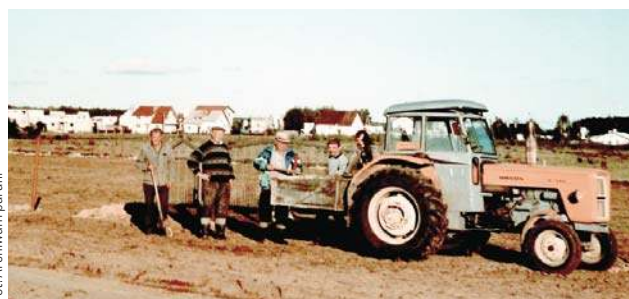
Chwile przed rozpoczęciem budowy kościoła w Jamielniku
