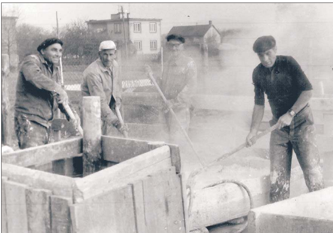
Budowa kościoła Miłosierdzia Bożego rozpoczęła się w stanie wojennym. (fot. archiwum parafialne)
