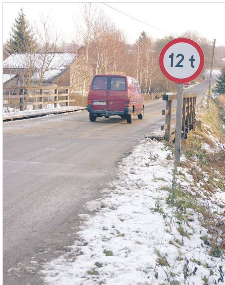
Most nad Jodłówką jest ostatnim drewnianym na drodze powiatowej.
