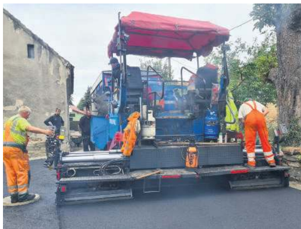
Na drodze wylano dwie warstwy asfaltu. Każda miała 4 cm grubości
