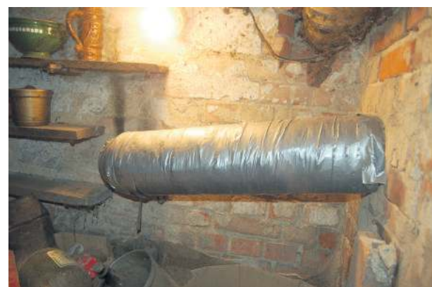
Taki przewód kominowy znalazł się jakiś czas temu w piwnicy naszego Czytelnika
