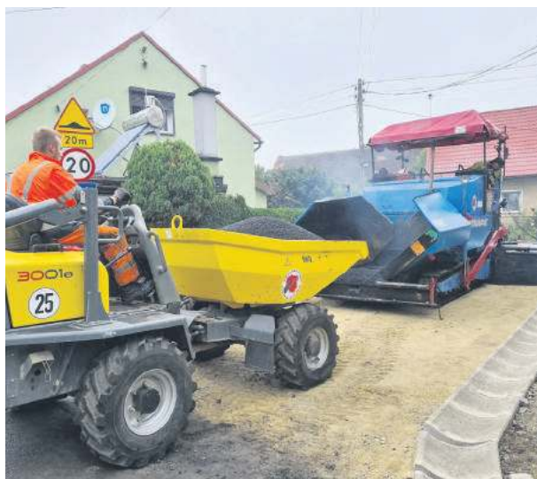
Firma zakończyła prace 14 września, a odbiór techniczny zaplanowano w najbliższych dniach
