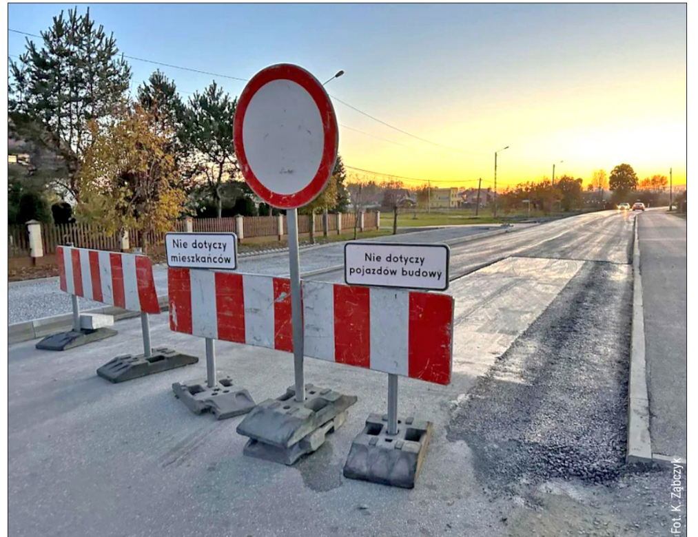
Aż cztery drogi powiatowe doczekają się remontu. Powstaną m.in. nowe chodniki, czy nawierzchnie asfaltowe.
