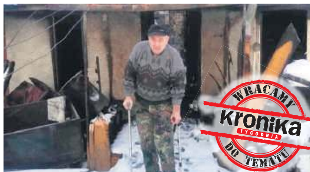
Budynek nie nadaje się do użytku.
