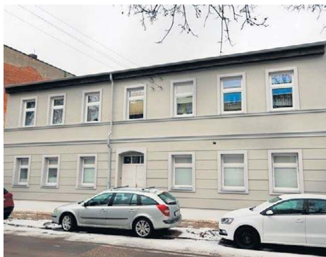
Popielatą fasadę budynku przy ul. Leszczyńskiego 14 po remoncie zdobiją jaśniejsze gzymsy i opaski wokół okien
