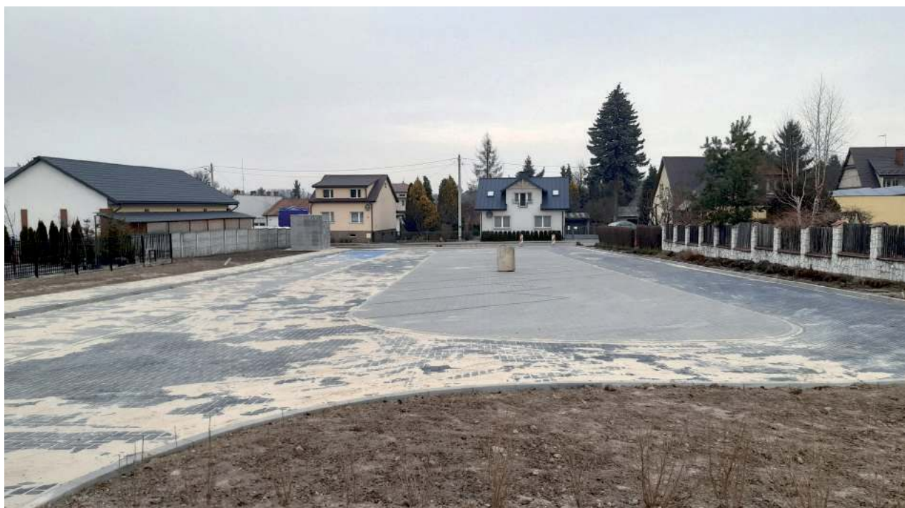
W lewym dolnym rogu, od strony ul. Kurowskiej stanęła toaleta. Na placu wydzielono 25 miejsc parkingowych - 20 dla samochodów osobowych, 2 dla autobusów i 3 dla pojazdów, którymi poruszają się osoby niepełnosprawne
