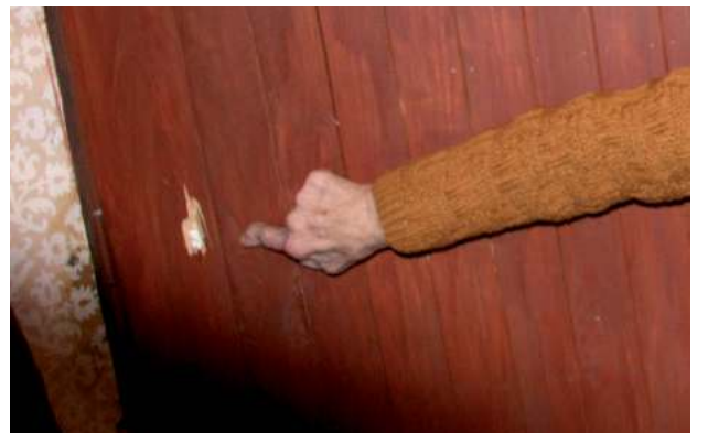
Otwór wylotowy po wewnętrznej stronie drzwi
