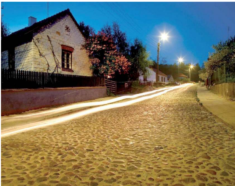
Fragment odcinka na ul. Lubelskiej od strony zamku liczy ponad pół kilometra. Droga powstała latach 60 XX wieku
