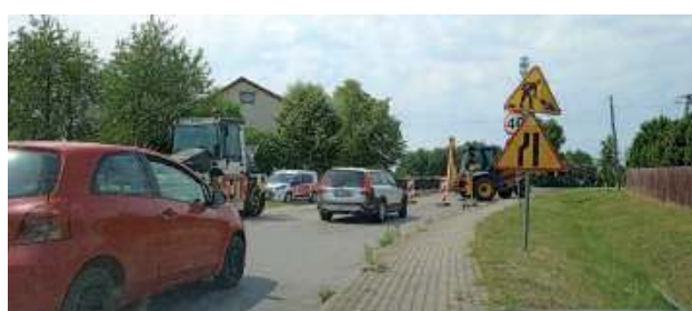
Tuż przy skrzyżowaniu w Konorzatce w stronę Woli Gułowskiej stoi sygnalizator świetlny
