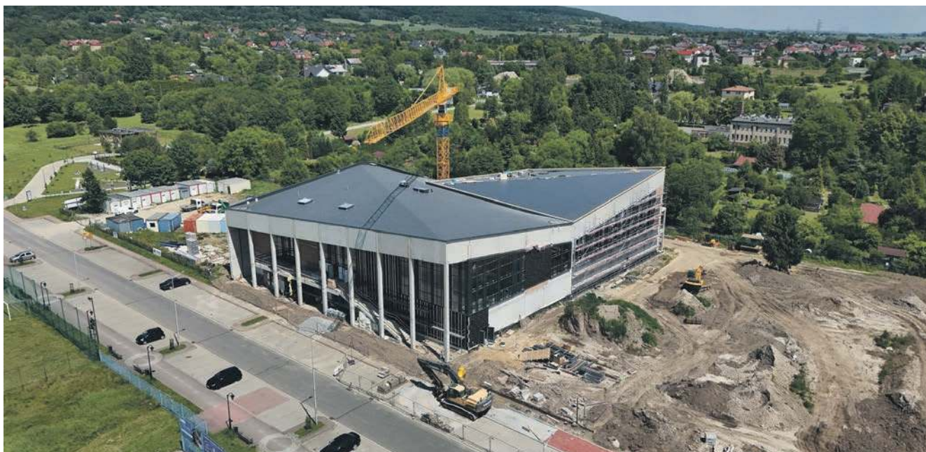
Tak obecnie wygląda powstający w Krzeszowicach basen
