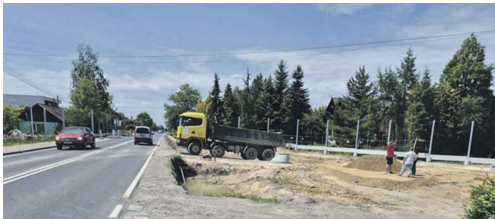
W Krzeszowicach wkrótce zacznie się budowa ronda
