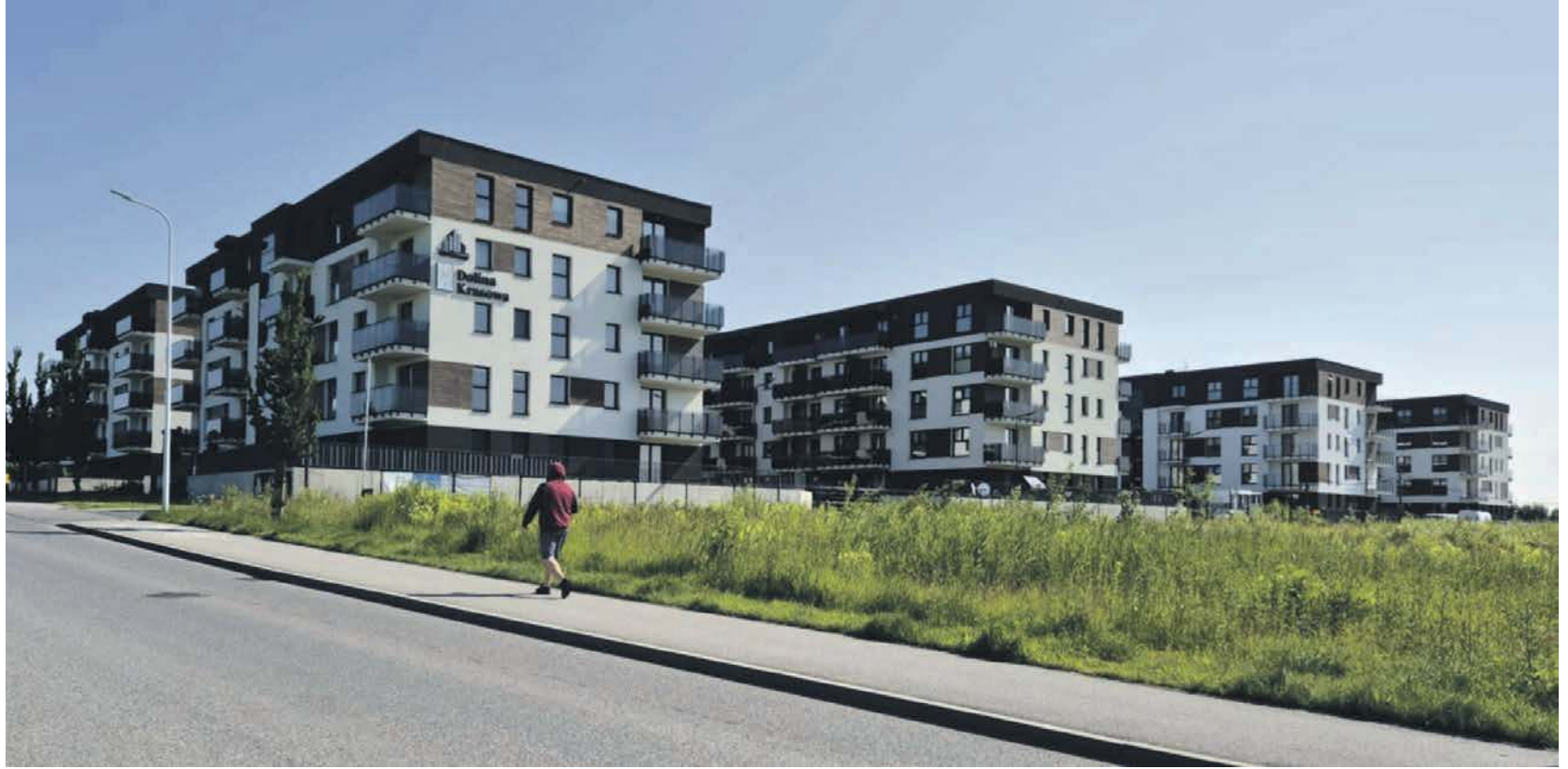
Nowe osiedle w Krzeszowicach. Za parę lat jeszcze się rozrośnie
