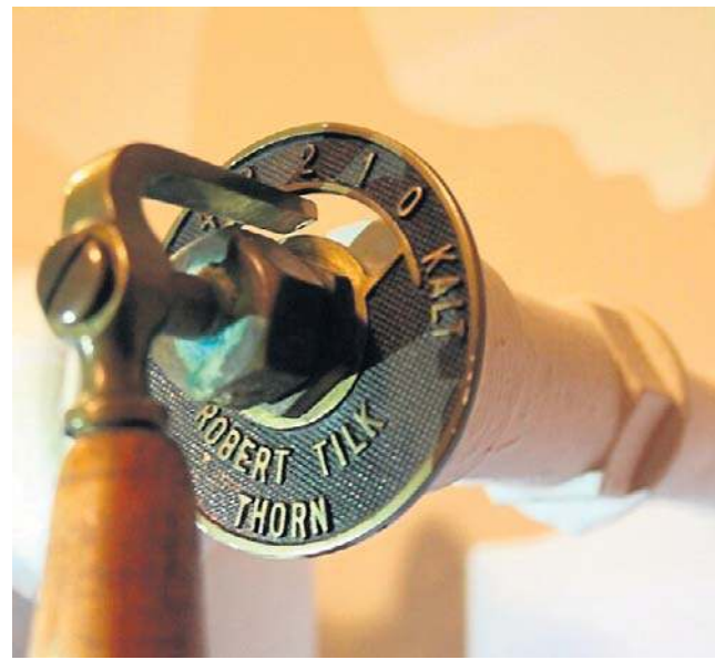
Firma Tilka produkowała o montowała instalacje co
