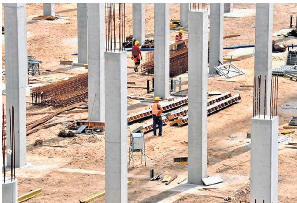
Dzięki technologii modułowej budynki powstają sprawniej i precyzyjniej
