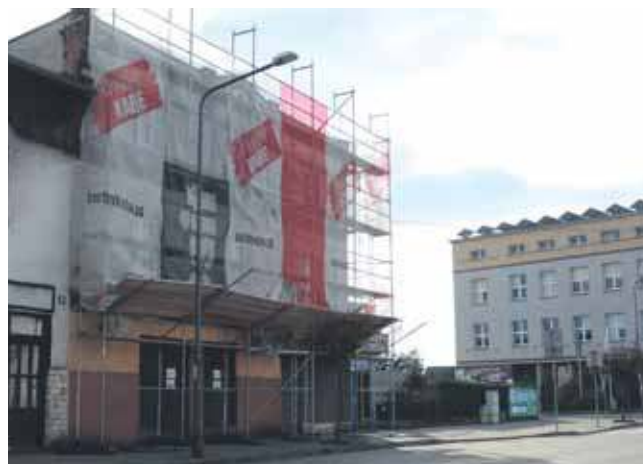
Dom przy ul. 1 Maja w Kaletach jest ostatnim z trzech, które w ramach jednego projektu zostały poddane termomodernizacji
