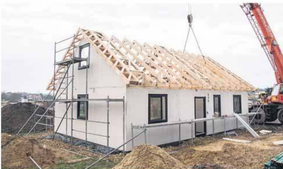
Stan zewnętrzny zamknięty na działce klienta w 5 dni!
