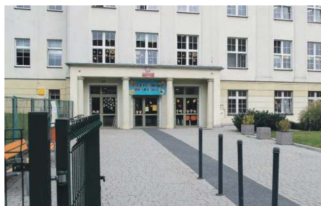
W SP 1 wykonane zostały prace ułatwiające funkcjonowanie w szkole osób niepełnosprawnych
