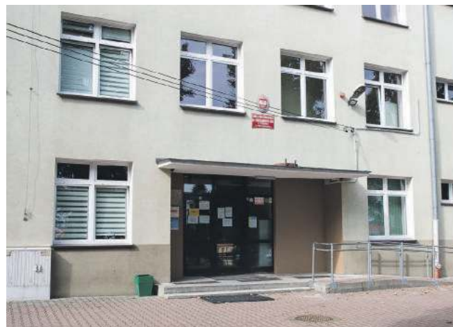
Remonty toalet w SP 3 jeszcze trwają
