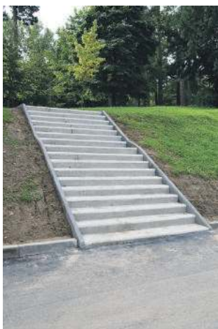
Schody do parku zostały już wyremontowane
