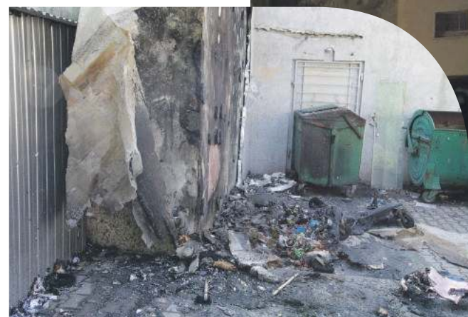
W drugim pożarze spaleni uległo już ogrzewanie ściany budynku
