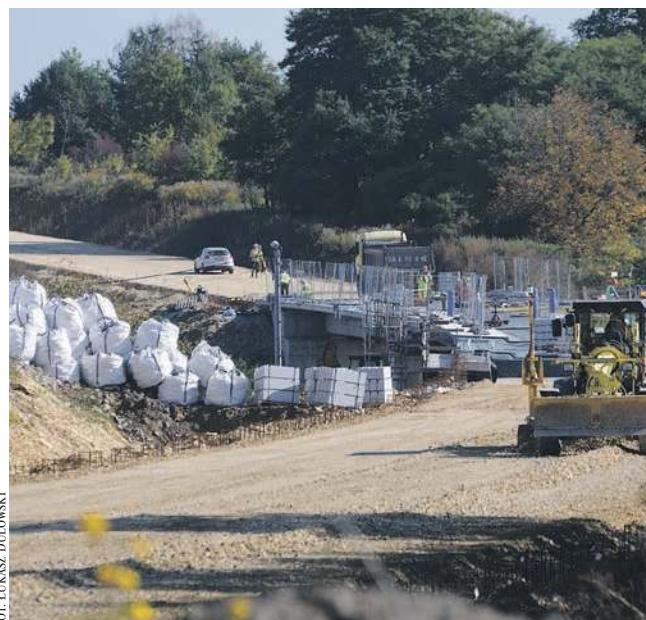
Budowana estakada w Byczynie
