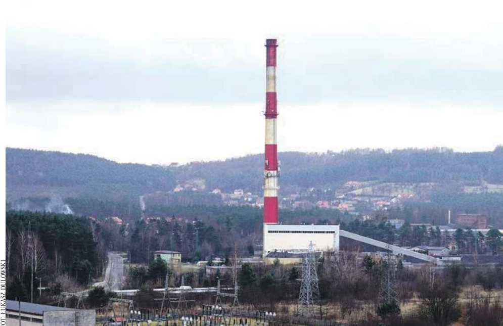
Spalarnia odpadów ma powstać na terenie ciepłowni przy Pogorskiej w Chrzanowie
