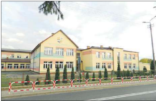
Jedną z kluczowych inwestycji była kompleksowa termomodernizacja budynku Zespołu Szkół w Sławatyczach wraz z montażem instalacji fotowoltaicznej
