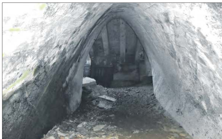
Tunel w masywnym budynku
