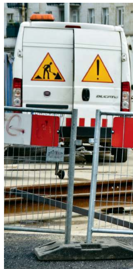
Trwa intensywna praca przy wymianie torowisk na pl.
