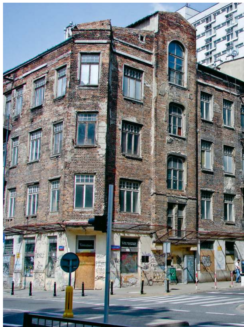
Narożna kamienica przy ul. Żelaznej 66 i dekoracyjne płytki z 1911 r. w przejeździe bramnym | fot. Fotopolska.pl
