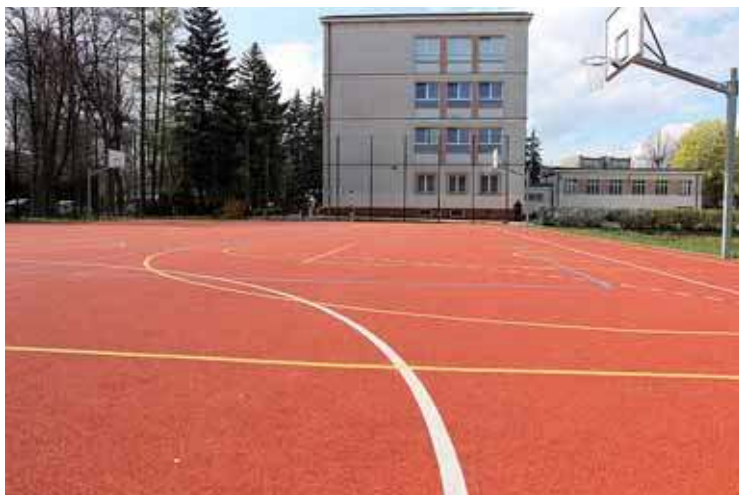
Wyremontowane boisko przy ZS nr 1 w Ciechanowie
