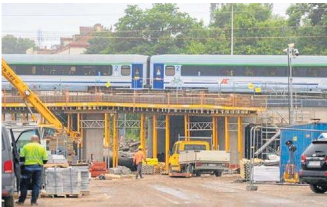
Wiadukt nad ul. Szczecińską w Słupsku nadal w remoncie
