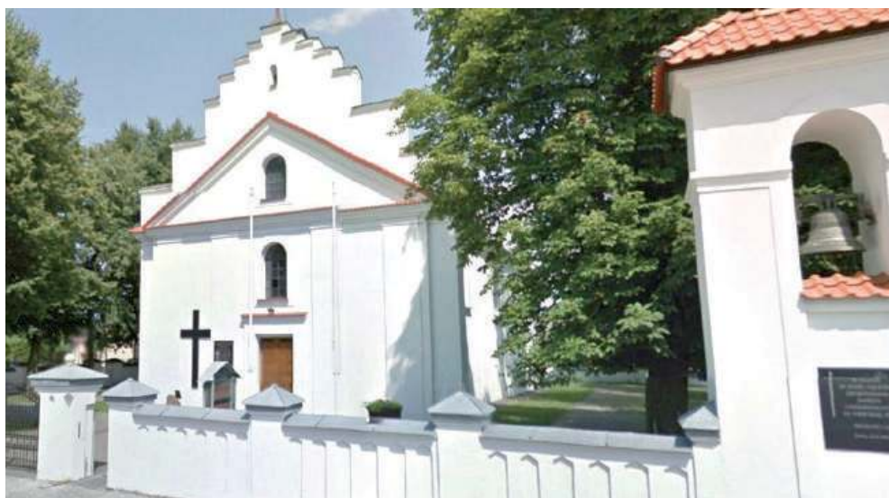
W Drelowie szykuje się gruntowny remont zabytkowej Parafii Rzymskokatolickiej pw. Niepokalanego Poczęcia NMP
