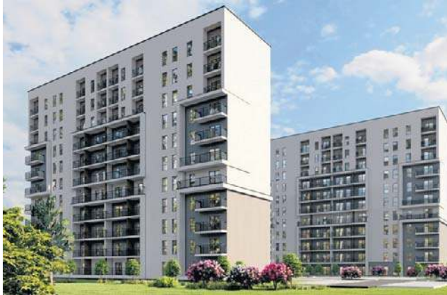
Przy ul. Wspólnej powstaną dwa kolejne wieżowce mieszkalne SIM Podkarpacie
