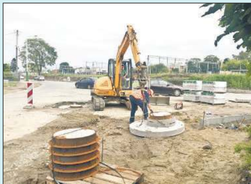
Trwa budowa ronda przy sądzie w Dębicy.
