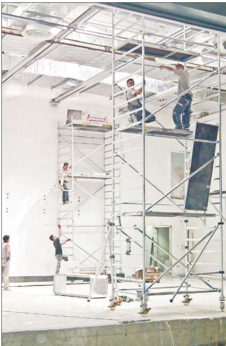
Prace w Morsie wciąż trwają. Tak wewnątrz, jak i na zewnątrz budynku.
