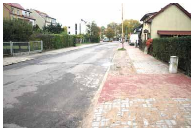
Zdjęcie z dnia wczorajszego, czyli z czwartku 26 października 2023 r. Chodnik, jak widać, został uzupełniony.
