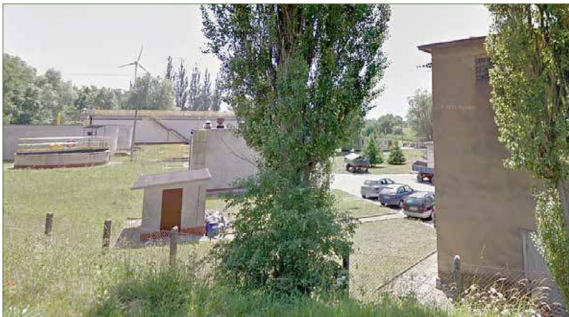
Budowana w latach 70-tych (modernizowana w latach 90-tych) oczyszczalnia przy ul. Zamkowej przestaje spełniać aktualne normy środowiskowe
