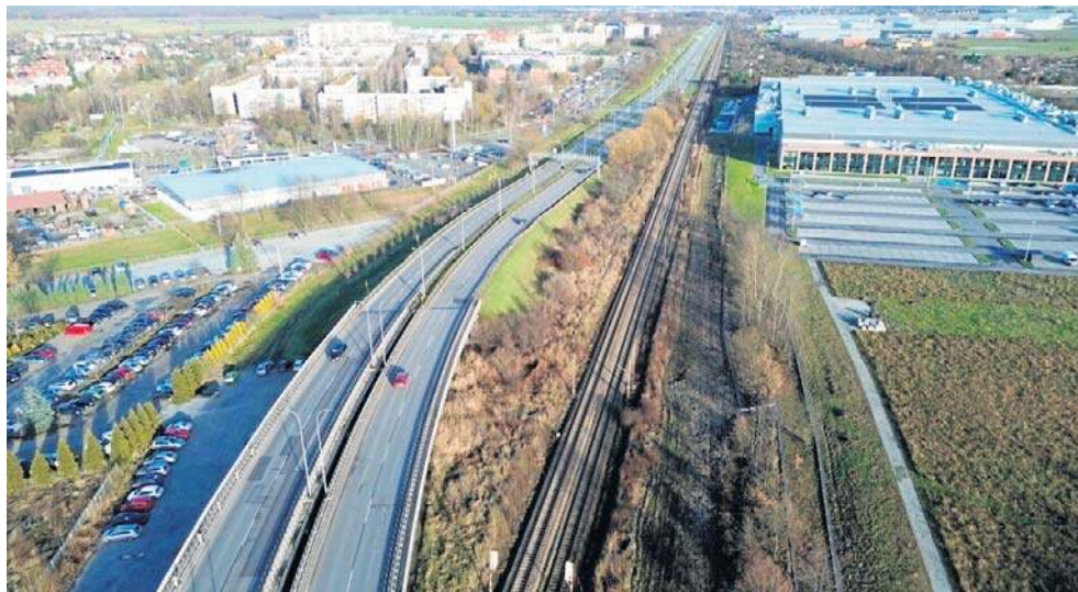
Estakady (dł. 340 m) powstały w 1983 i zapewniają przejazd nad torami kolejowymi
