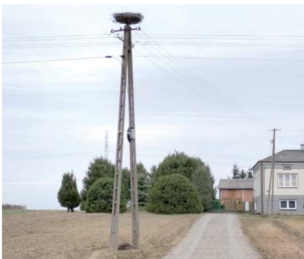
Gniazdo zostało przeniesione na pobliski słup energetyczny
