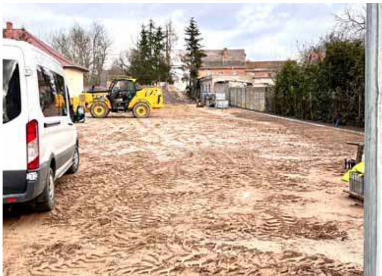
Przy ulicy Ogrodowej w Dolicach rozpoczęła się budowa targowiska gminnego Mój Rynek
