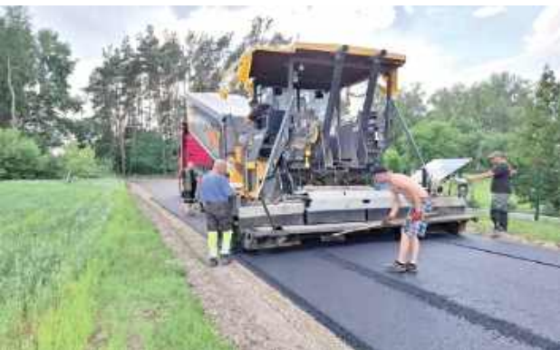
Zakres prac obejmował również przebudowę wjazdu do świetlicy wiejskiej oraz połączenia drogi gminnej z drogą powiatową
