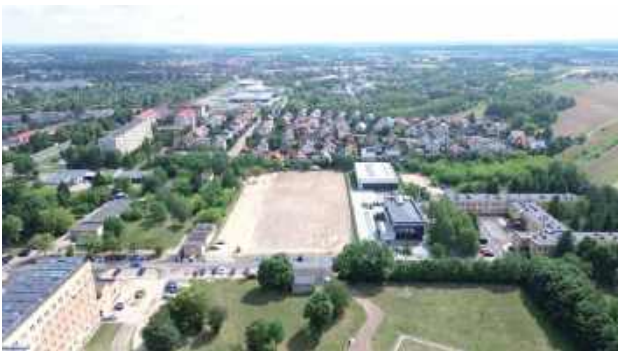
Inwestycja została zrealizowana na terenie szpitala. Obejmowała przebudowę drogi wewnętrznej, wykonanie nowych chodników oraz zatok parkingowych
