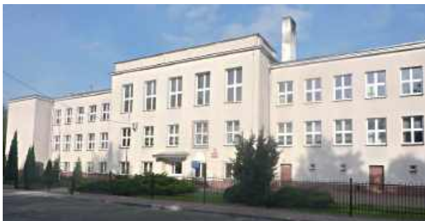
Podczas prowadzenia robót konieczne było czasowe przeniesienie części uczniów do szkoły w innej miejscowości, natomiast pozostali korzystali z pomieszczeń w budynku po byłym liceum
