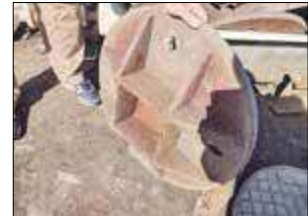
Policjanci na ul. Kościuszki niemal najechali na otwartą studzienkę kanalizacyjną
