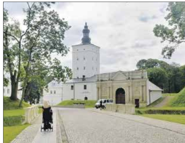
W ramach projektu „Rewaloryzacja i modernizacja zespołu zamkowo-parkowego Radziwiłłów w Białej Podlaskiej” przebudowano most przy głównym wjeździe na ten teren
