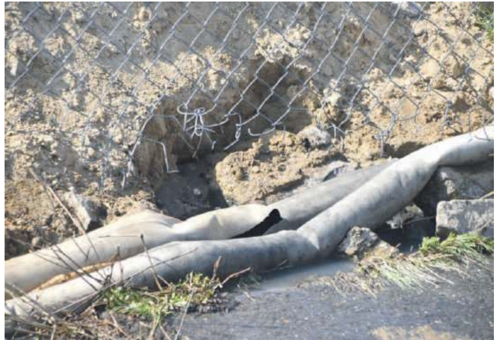
Ktoś uszkodził jeden z tych węży, którym ścieki płynęły do specjalnego zbiornika
