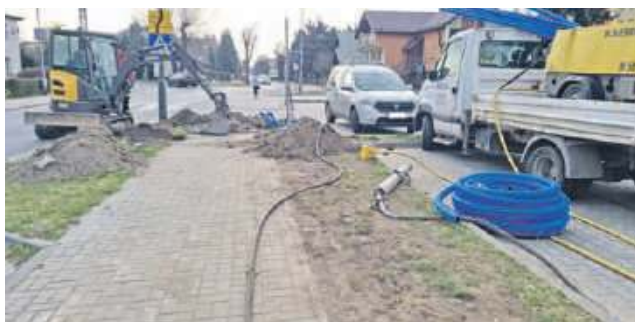
Rozpoczęły się roboty przy modernizacji drogi na ul. Zacisnej
