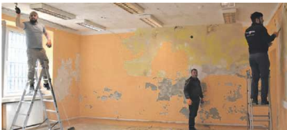
Prace idą pełną parą
