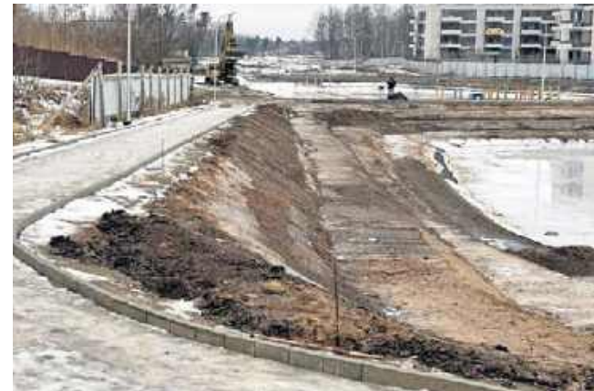
Na radomskim Wacynie budowany jest park z ośmioma stawami. Tak obecnie wygląda stan robót.
