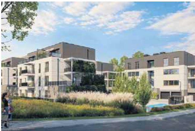
Inwestycja obejmuje 110 lokali w 10 budynkach wielorodzinnych oraz 12 segmentów jednorodzinnych
