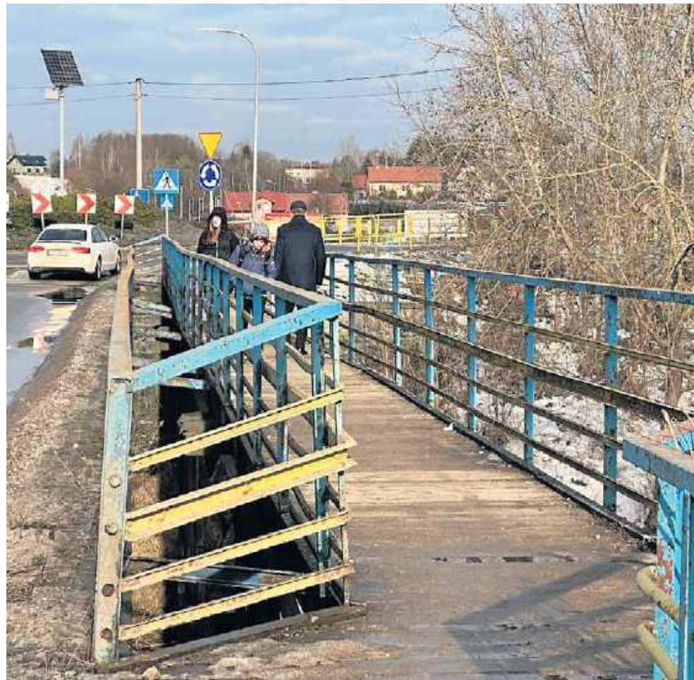
Remont mostu w Kunowie ruszy w marcu. Będzie dostępny dla pieszych
