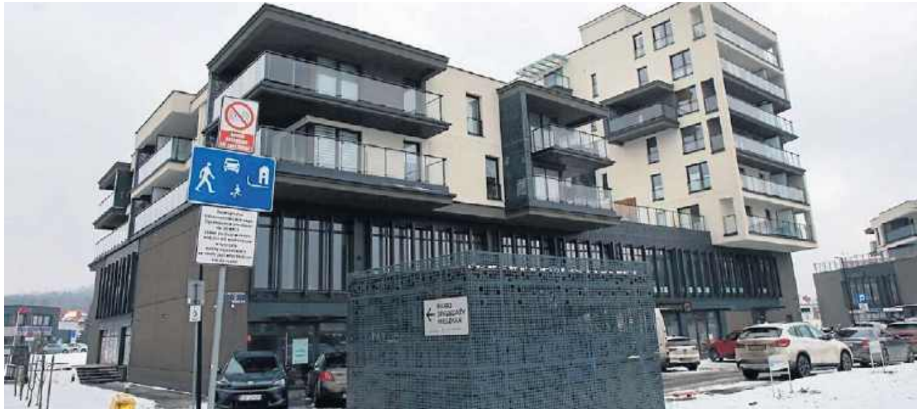
Deweloper Perfect Alfa informuje o zakończeniu prac w V etapie inwestycji
