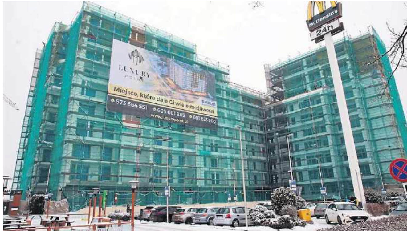
Luxury Point powstaje w centrum Kielc przy alei Solidarności i jest w trakcie realizacji
