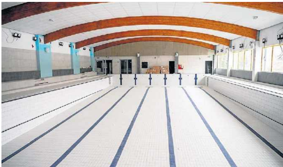
Wyremontowana nieka dużego basenu na krytej pływalni w Sandomierzu.
