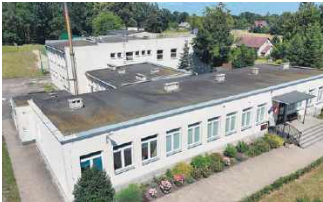
PSP w Kończycach-Kolonii przed termomodernizacją
