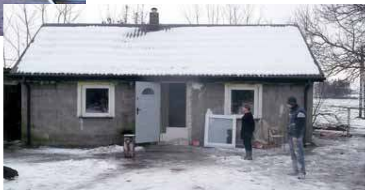
Ten dom po odbudowie
