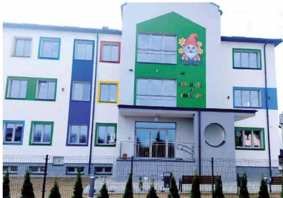
Tak wygląda budynek po remoncie
