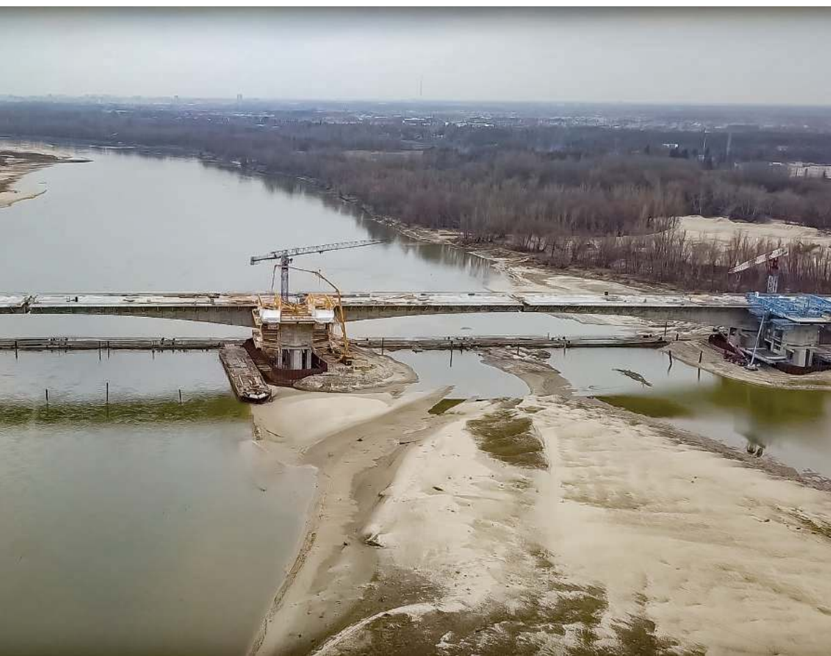
Kończy się właśnie betonowanie mostu w ciągu POW, łączącego Wilanów z Wawrem | fot. YouTube/d
