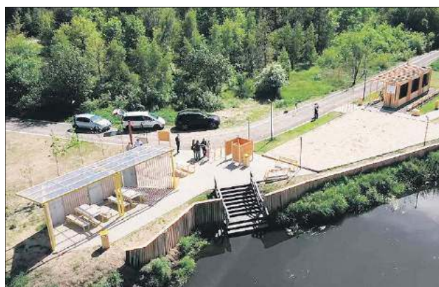
Tężnia, plaża i zejście do rzeki – tak zagospodarowano teren nad Krzną w okolicy ul. Brzegowej
