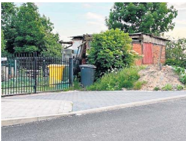
Tak prezentuje się wyremontowana droga w Sulimicach z chodnikiem i z dojazdem do posesji...
