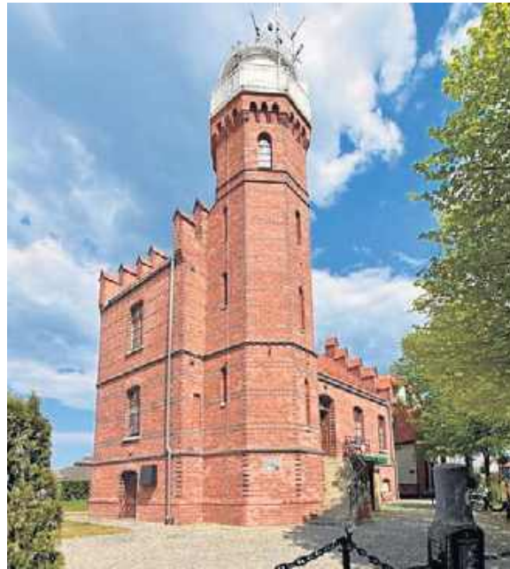
Ceglana latarnia w Ustce
