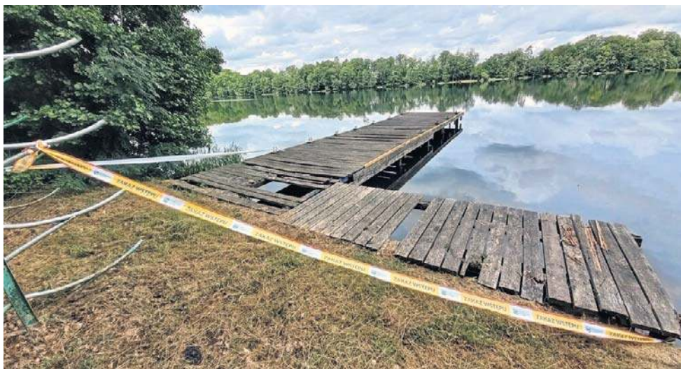
Część pomostów funkcjonuje jako samowole budowlane
