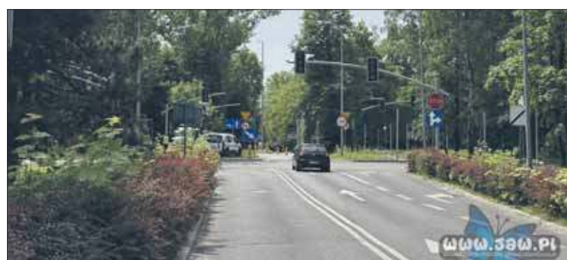
Prace przy budowie ul. Nowoszczakowskiej i przebudowie skrzyżowania z ulicą Grunwaldzką
