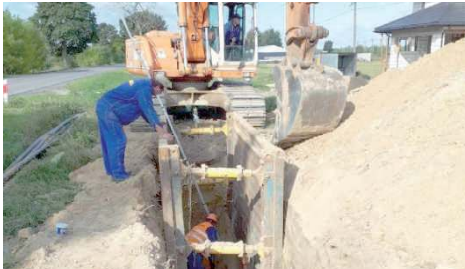
Nowa sieć wodociągowa i kanalizacyjna po północnej stronie Babic, będzie miała ok. 2,5 km długości
