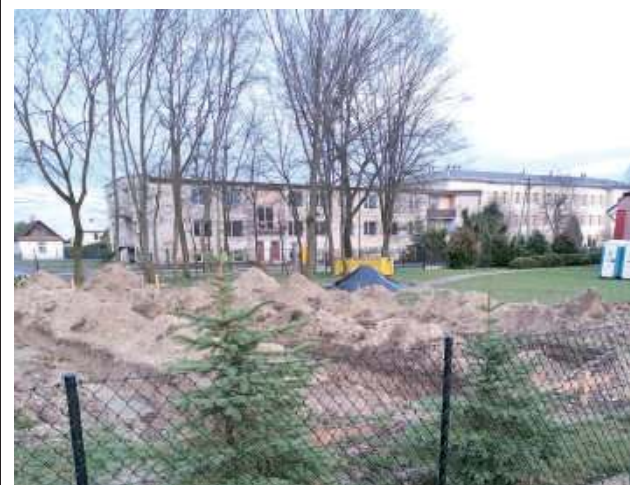
Trwa budowa posterunku policji w Turobinie
