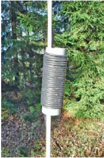
Fot. 4. Umocnienie dławika dla zmniejszenia jego obciążenia mechanicznego. Na jego szczycie występują wysokie napięcia w.cz. i dlatego powinien on się znajdować możliwie wysoko nad ziemią
