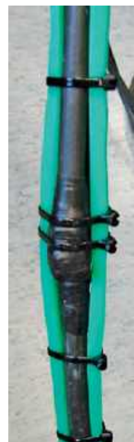
Fot. 3. Jako wzmocnienie połączeń służy plastikowe łubki, do których wiązadłami są przywiązane końce kabli
