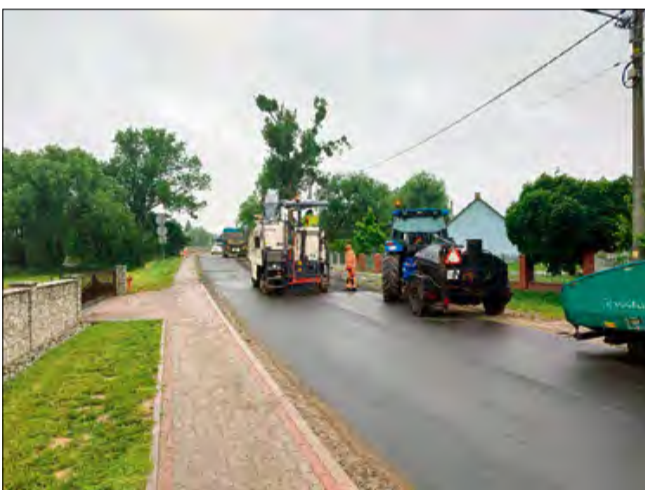
W ramach usuwania popowodziowych zniszczeń powstanie praktycznie nowa droga - poszerzona i wyposażona w ścieżkę pieszo-rowerową.
