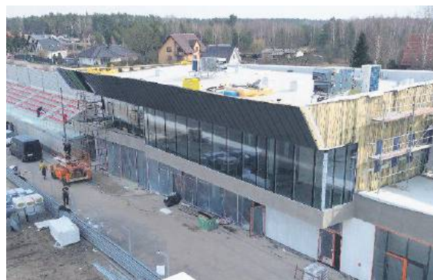
W Biłgoraju powstaje nowoczesny obiekt.
