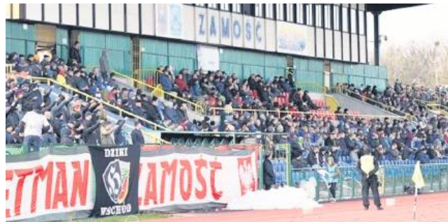
W ramach zadania zaplanowano budowę nowego boiska i bieżni, pawilonu sprawozdawców na trybunach, a także części miejsc dla kibiców.
