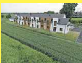
2 segmenty w nowocześnie zabudowie szeregowej, w stanie deweloperskim w Łukowie przy ul. Gospodarskiej, 885 851 158
