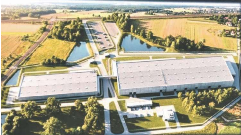
Nowa fabryka „Jelcz” stanie w Miłoszycach na styku Jelcza-Laskowice i Miłoszyc, przy ul. Długiej, Głównej i Inżynierskiej, nieopodal miejsca, gdzie był stary wieżowiec JZS
