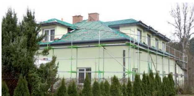
Świetlica w Oblasach niebawem zostanie przekształcona w Centrum Integracji Wiejskiej. Prace remontowe prowadzone są etapami
