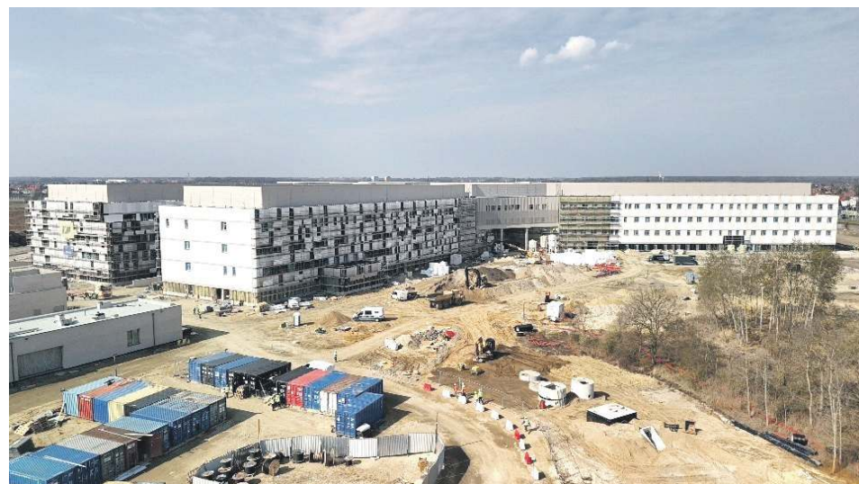
Budowa Nowego Szpitala Onkologicznego idzie pełną parą
