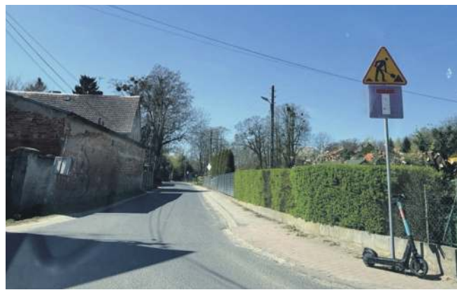
Wjazd od ul. Mostowej
