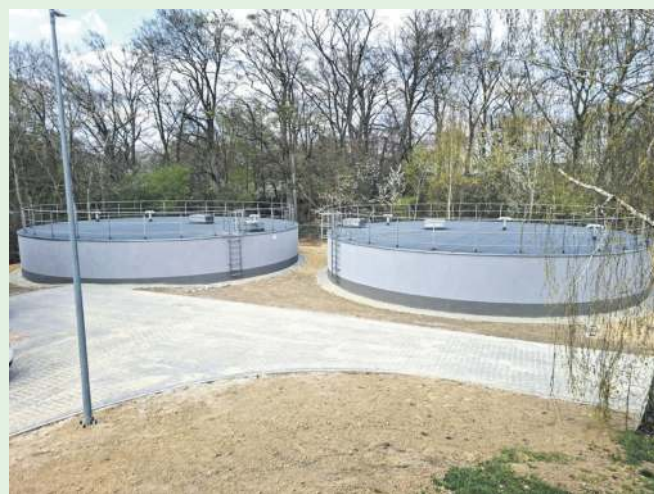
Ukończona budowa dwóch zbiorników wody w Machnicach
