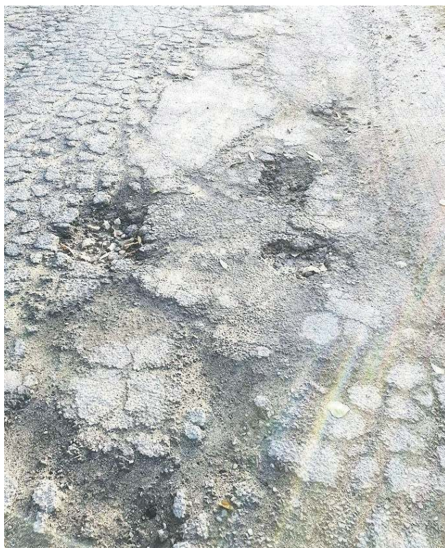
FOT. ZDJEŃCIE POBUDOWE
