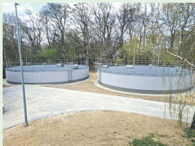
Ukończona budowa dwóch zbiorników wody w Machnicach
