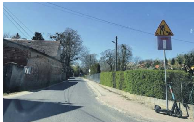
Wjazd od ul. Mostowej
