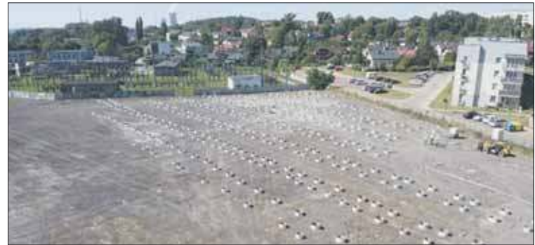
Na działce ma stanąć ponad 12 tys. paneli fotowoltaicznych
