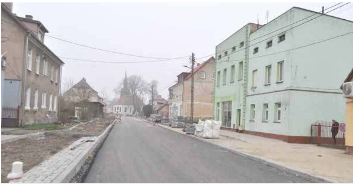
Na Sikorskiego położono już pierwszą warstwę masy bitumicznej. Foto dzięki uprzejmości M. Kwiryn
